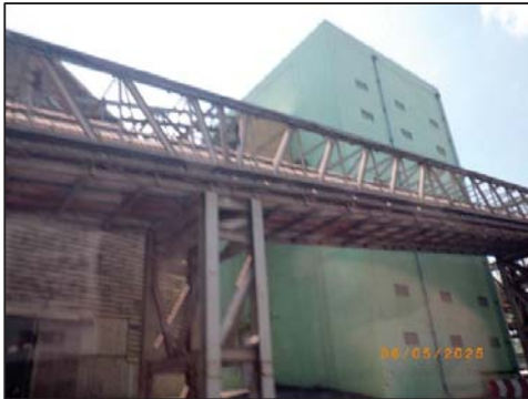
รูปที่ 2-8 สายพานลำเลียงแบบระบบปิด
