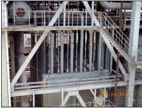
รูปที่ 2-63 Rapid Drain Piping System ของหม้อไอน้ำ
