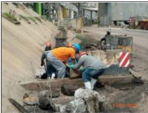
รูปที่ 2-31 การขุดลอกรางระบายน้ำ
