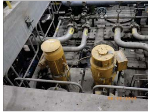
รูปที่ 2-70 DC Oil Pump ภายในโรงไฟฟ้า
