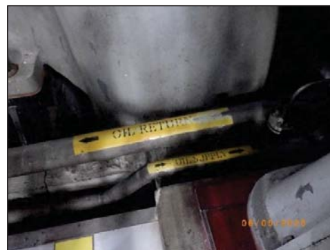
รูปที่ 2-68 ระบบท่อน้ำมันเลี้ยงแบร์ริง ของ Turbine & Generator
