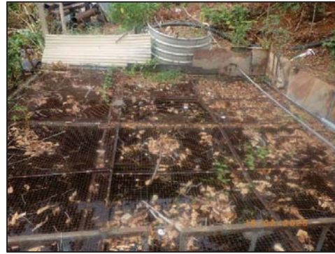
รูปที่ 2-28 ตะแกรงดักขยะมูลฝอย ก่อนระบายน้ำลงสู่ระบบบำบัดน้ำเสีย
